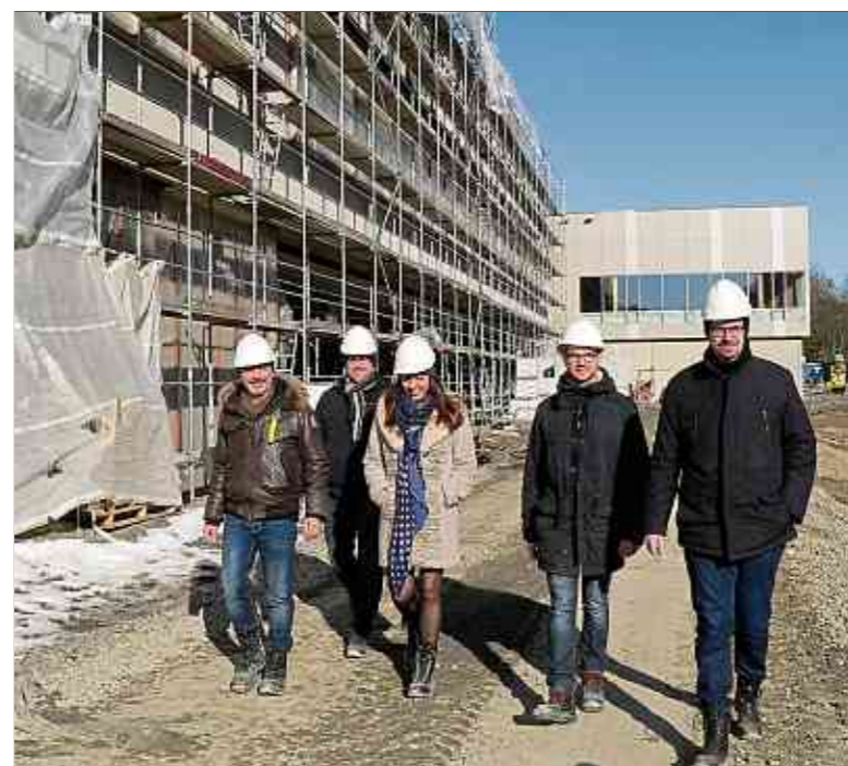
Auch dem Führungsteam des Lycée Edward Steichen um Direktor Jean Billa (l.) stellt sich die Schule bei jeder Baustellentour mit Architekt Patrick Diederich (2. v. r.) wieder mit neuem Gesicht dar. (FOTOS: JOHN LAMBERTY)
